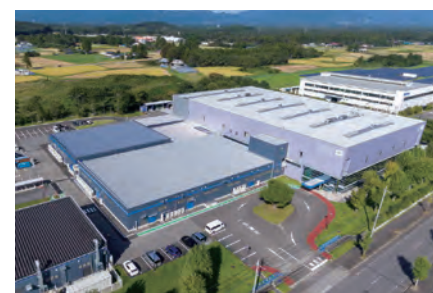
● 栃木事業部 (大阪シーリング印刷株式会社 栃木工場内)
